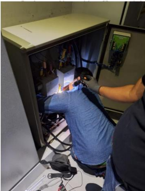
Imagen 4: Desconexión transferencia antigua
