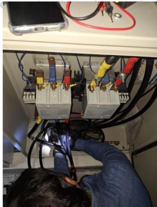
Imagen 5: Desconexión transferencia antigua
